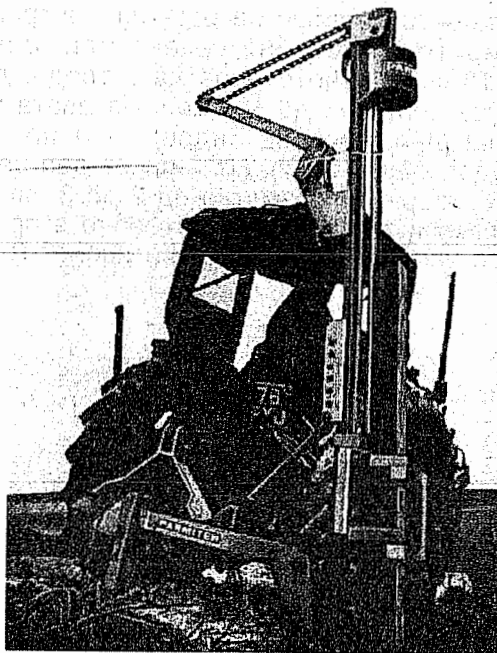
Сл.36 Изглед на машина за набивање на столбови во работа
